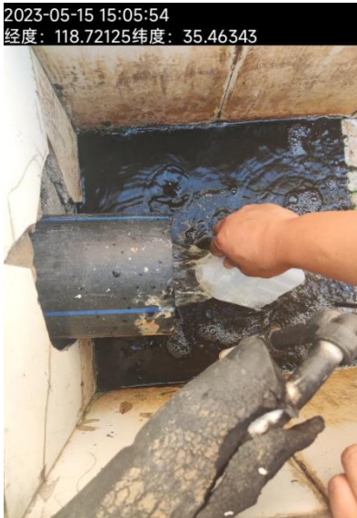
图 1: 污水现场照片
