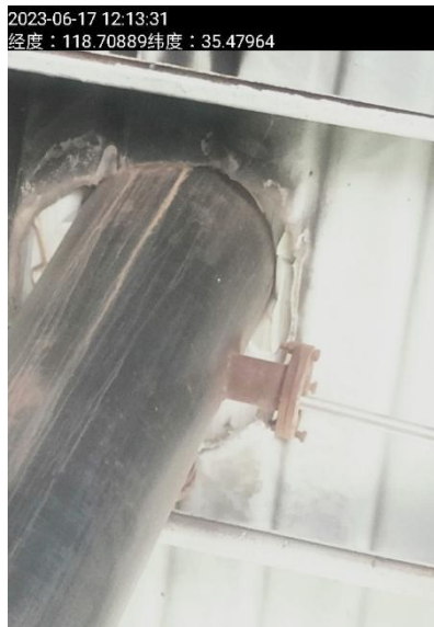
图 2: 固定源现场照片
