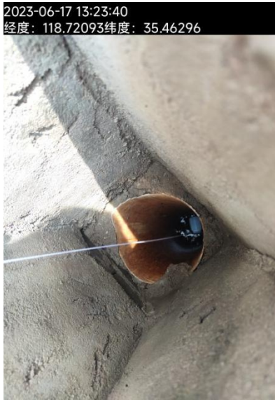
图 4: 地下水现场照片
