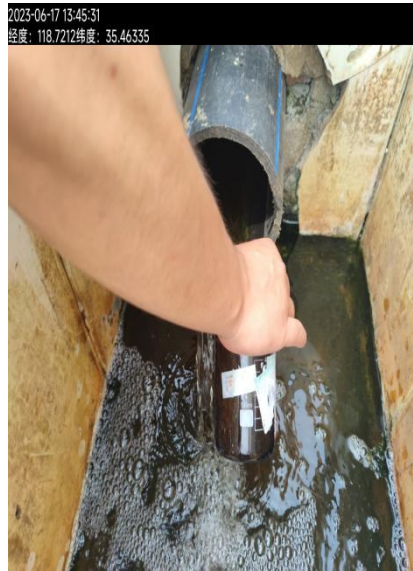
图 5: 废水现场照片
