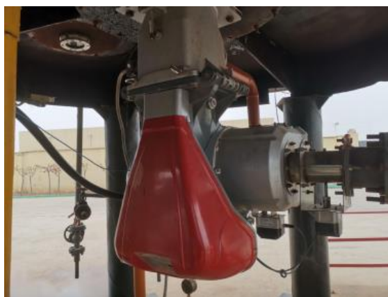
加热炉低氮燃烧器
