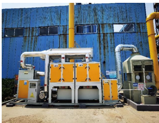
旋流喷淋+初效过滤、活性炭吸附脱附+催化燃烧
