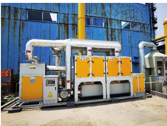
旋流喷淋+初效过滤、活性炭吸附脱附+催化燃烧
