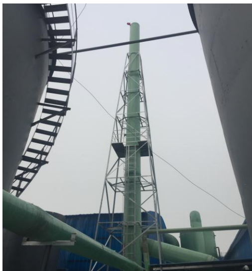
污水处理站排气筒
