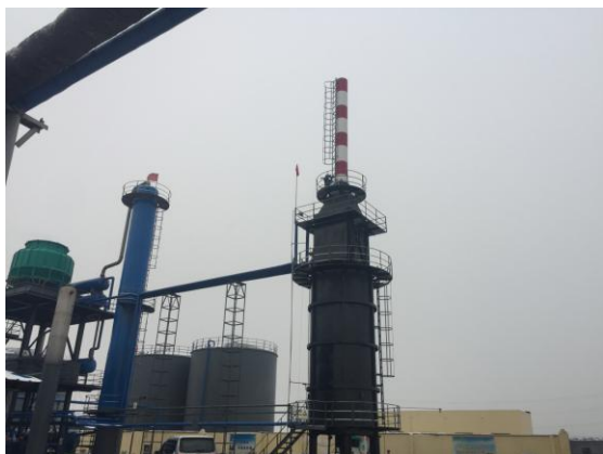
加热炉排气筒
