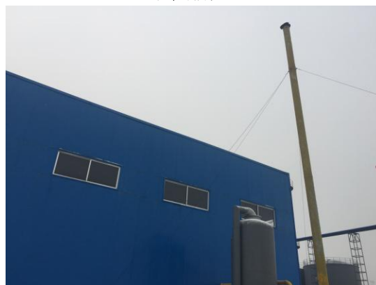
精制车间排气筒
